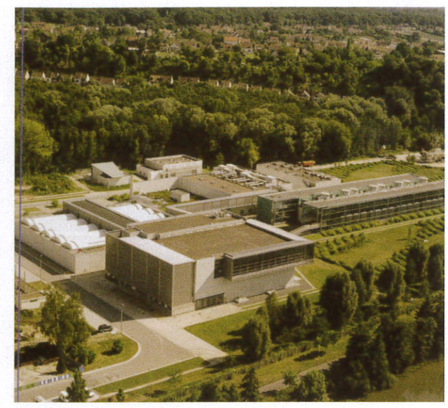
L'usine de production d'eau potable de Méry-sur-Oise
